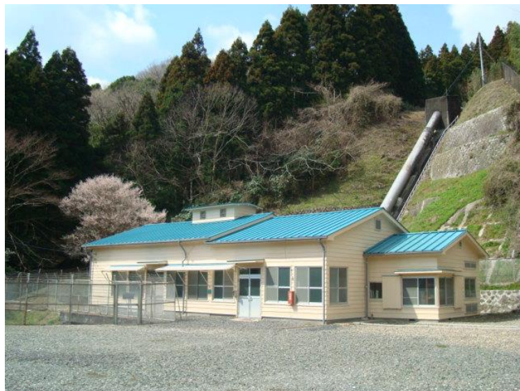
賀美発電所(本館、水圧鉄管)
