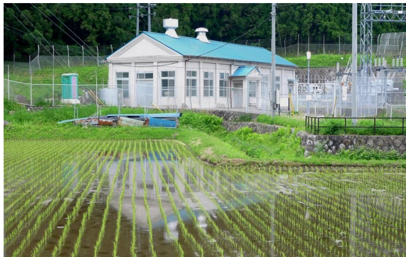
小里川発電所(本館、変電設備)
