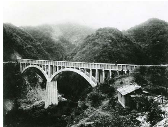
大正時代 建設当時の3号水路橋
