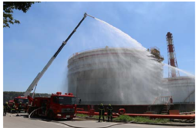
(消火活動にあたる新日鐵住金自衛防災隊)
