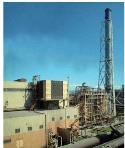
5号機ガスタービン・建屋全景
