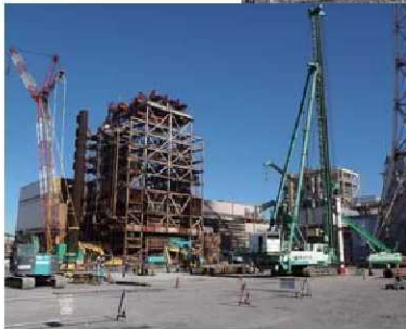
4号機ボイラ解体前
