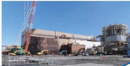
4号機ボイラ解体後
